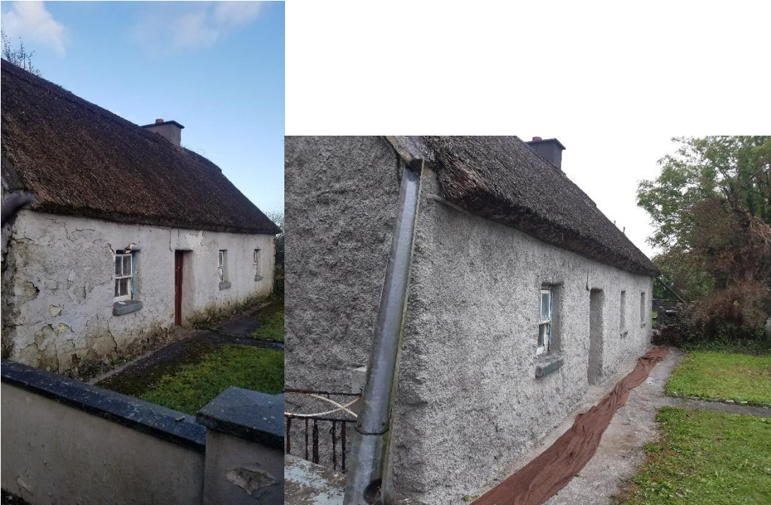
Deisiú ar rindreáil aoil, An Chlúid Riabhach
